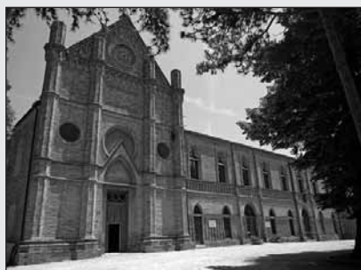
Corropoli, la Badia
